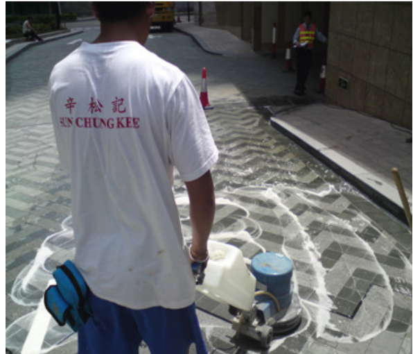
用洗地機(地台)洗刷物件表面及吐出之污漬
